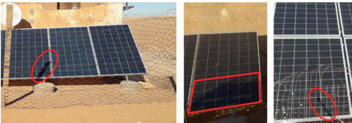
Figure 35. Exemples d'ombrage partiel de modules PV.
